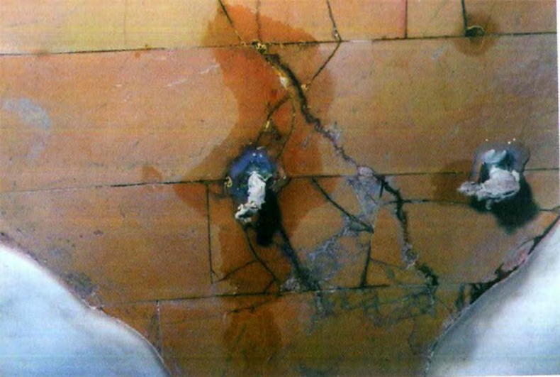
Zdjęcie w trakcie konserwacji. Dysze do wprowadzania masy iniekcyjnej przyklejono klejem termoplastycznym. Umieszczane w otworach wałki ligniny zabezpieczają przed wyciekaniem masy.
