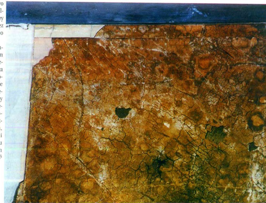
Widok po odjęciu cienkiej płytki marmurowej, elementu intarsji. Ciemne marmury klejono na zaprawę termoplastyczną zawierającą kałafonię i wypełniacz. Widoczne rysy i spękania powstałe w wyniku skurczu masy. View after the removal of the thin marble plate, an element of the inlay. The dark marble was attached with a thermoplastic mortar containing rosin and filler. The visible scratches and cracks are a result of the shrinkage of the mass.
